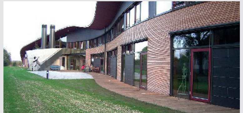
Edificio scolastico - Montessori School (Aufkirchen, Germany)
